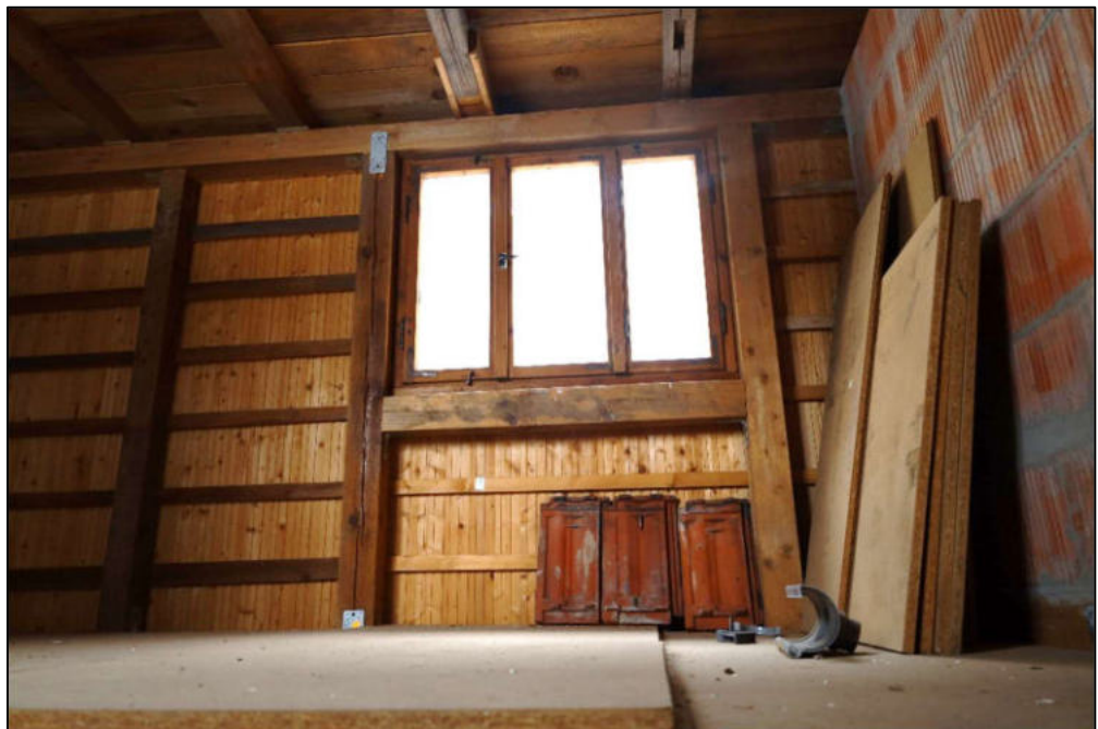
Abstellraum im Anbau - OG
