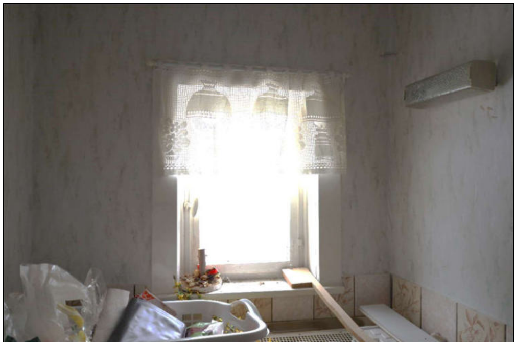
Küche – 1. OG (Seitengebäude)
