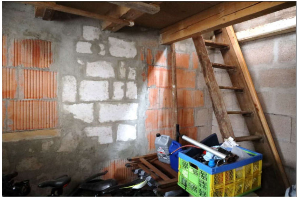
Abstellraum im Anbau - EG
