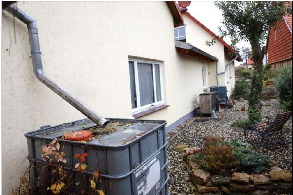
Ostansicht – Garage / Einfamilienwohnhaus
