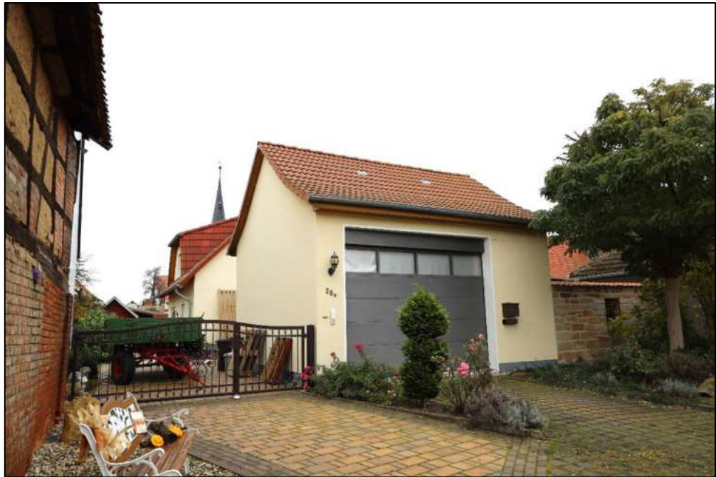
Südwestansicht – Garage / Einfamilienwohnhaus
