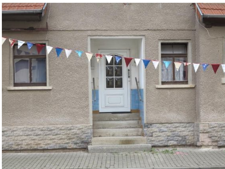
Hauseingang EG Straßenseite
