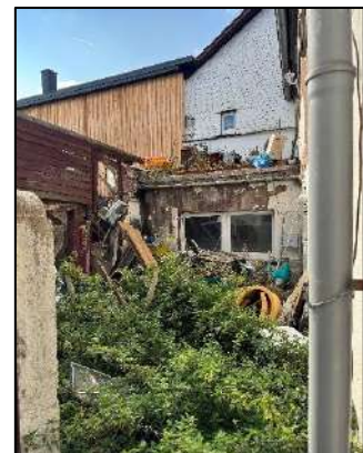
Blick in den Hinterhof mit seitlichem Anbau
