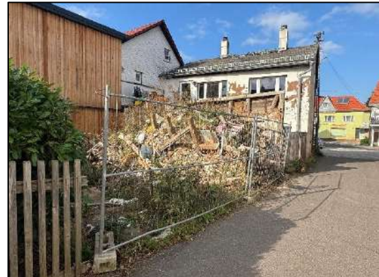
Straßenansicht - Hausrückseite mit Ruine (Blick von der Straße: „An der Böttchergasse“)
