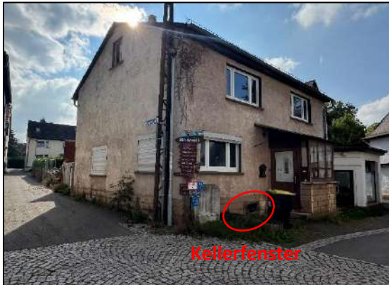
Straßenansicht – Einfamilienhaus mit Kellerfenster (Blick von der Straße: „Ecke“)
