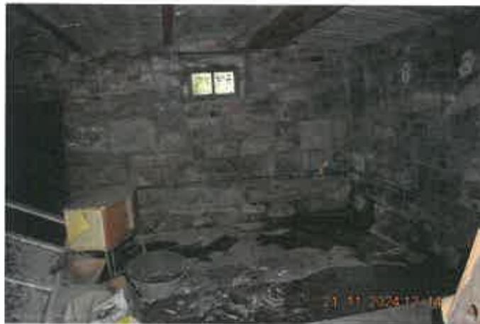
Kellerraum mit Nässeschäden (offensichtlich durch undichte ehemalige Klärgrube)
