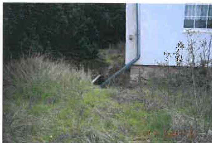
Einleitung der Oberflächenentwässerung in alte Klärgrube
