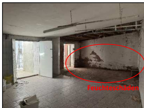
Innenansicht – Anbau von 2000 mit Feuchteschäden im hinteren Bereich
