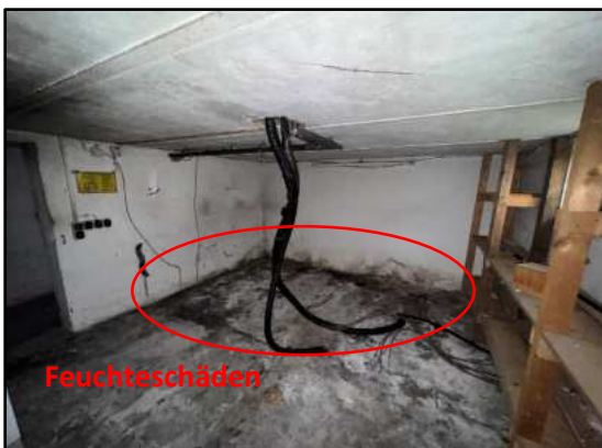
Lageraum 1 mit Resten der Kühlzapfanlage und Feuchteschäden an Wänden und Boden
