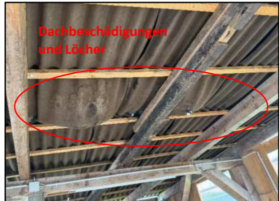
Dachbeschädigungen und Undichtigkeiten im Dach des Holzschuppen / Carports
