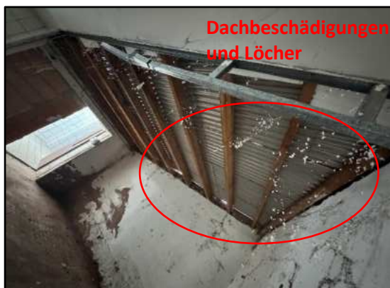
Dachbeschädigungen und Undichtigkeiten an einem Teil des Daches des Anbaus von 2000
