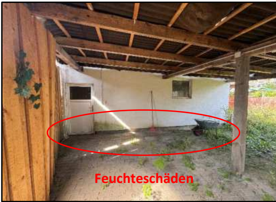
Innenansicht Carport mit Feuchteschäden an der Fassade des Anbaus von 2005
