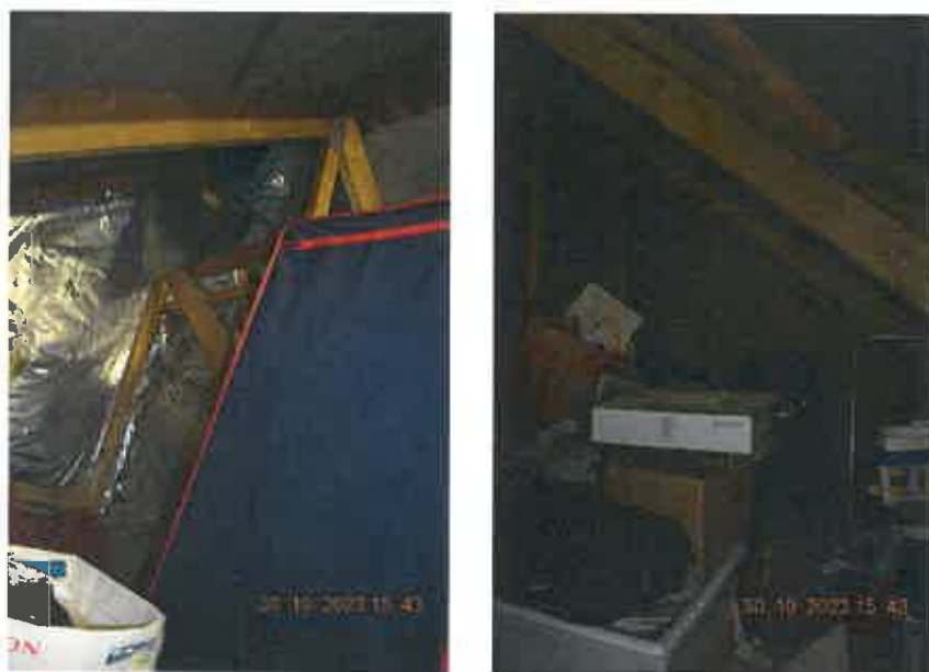
nicht ausgebauter Spitzbodenbereich
