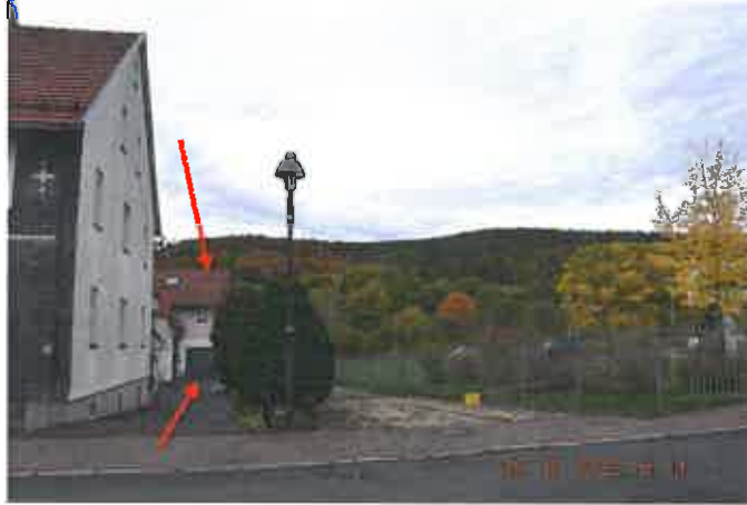
Außenansicht mit Zufahrt über Fremdflurstück
