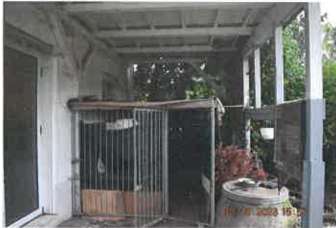
rückwärtige Freifläche unter Balkonkonstruktion
