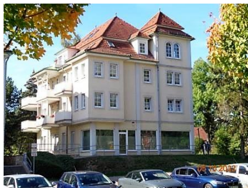
Bild 2: Wohn- und Geschäftsgebäude Eisenacher Straße 61 in 99867 Gotha; Nord-Ost-Ansicht
