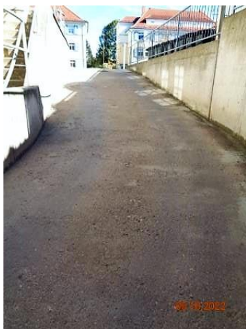
Bild 3: Zufahrt zur Tiefgarage
