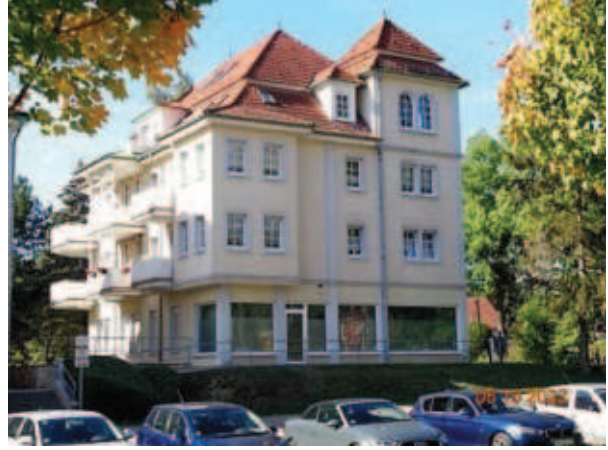
Bild 2: Wohn- und Geschäftsgebäude Eisenacher Straße 61 in 99867 Gotha; Süd-Ost-Ansicht
