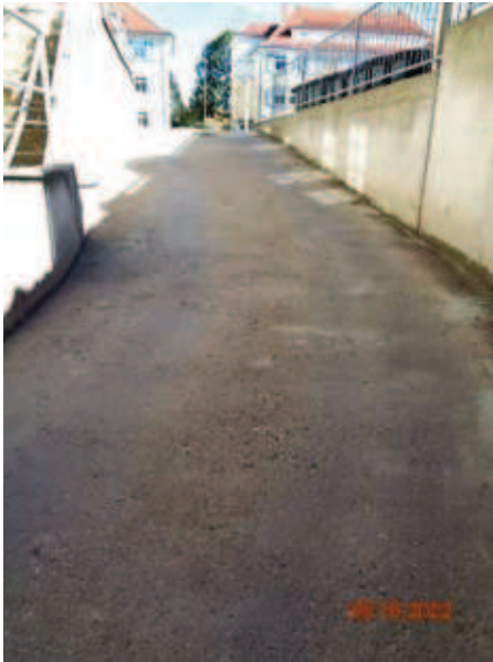
Bild 3: Zufahrt zur Tiefgarage
