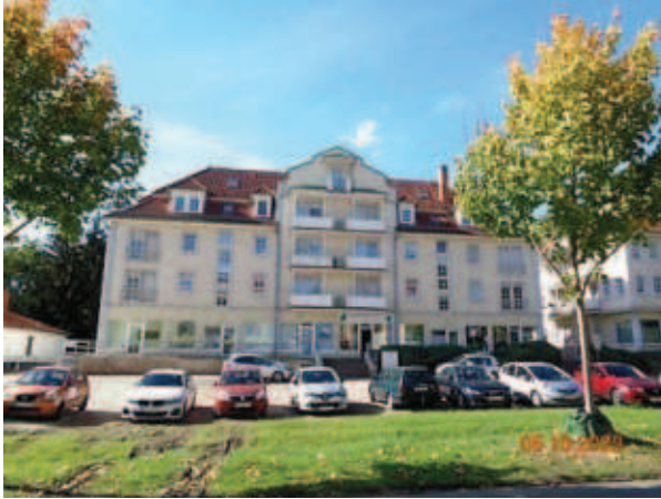
Bild 1: Wohn- und Geschäftsgebäude Prießnitzstraße 9 und 11 in 99867 Gotha; Ostansicht
