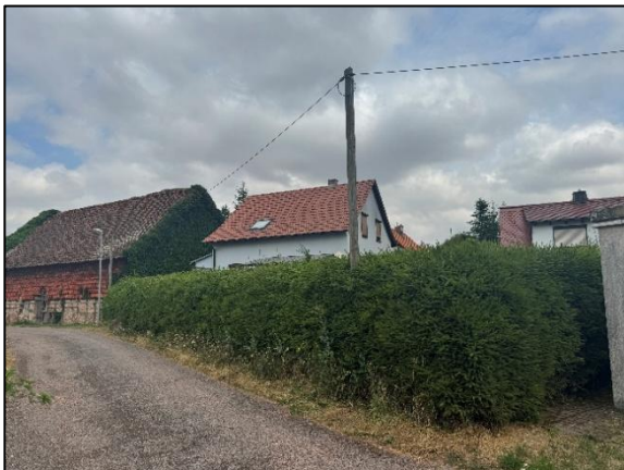
Außenansicht - Westliche und Südwestliche Grundstücksgrenze entlang der Straße „Am Dorfgraben“ mit blickdichtem Heckenbewuchs
