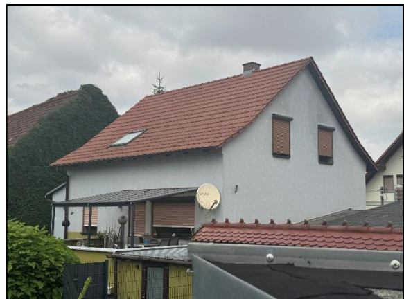
Außenansicht - Gebäuderückansicht des Einfamilienhauses mit Blick auf die überdachte Terrasse
