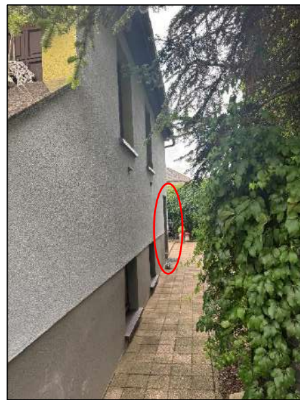
Außenansicht - Offener Weg in den hinteren Gartenbereich sowie weitere Eingangs-/ Ausgangstür vom Keller aus in den Garten
