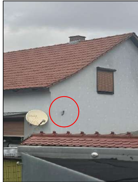
Außenansicht - Herausragendes Entlüftungrohr der wahrscheinlichen Ölheizung des Bewertungsobjektes
