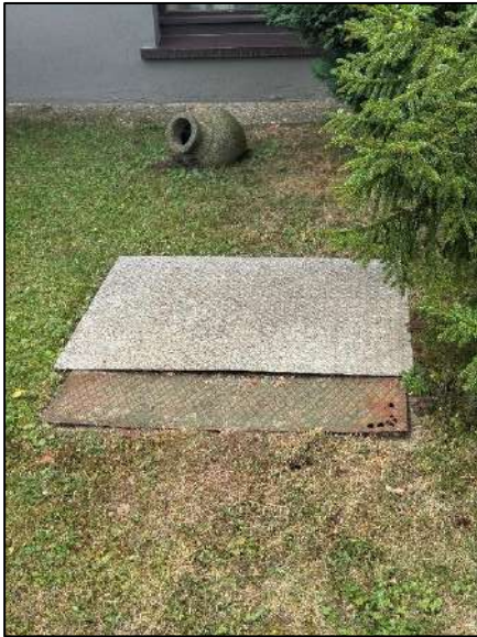
Außenansicht - Wahrscheinliche Klärgrubenabdeckung im Vorgarten
