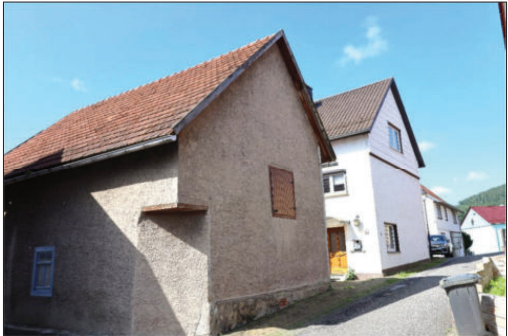
Nordwestansicht – Nebengebäude (Scheune)
