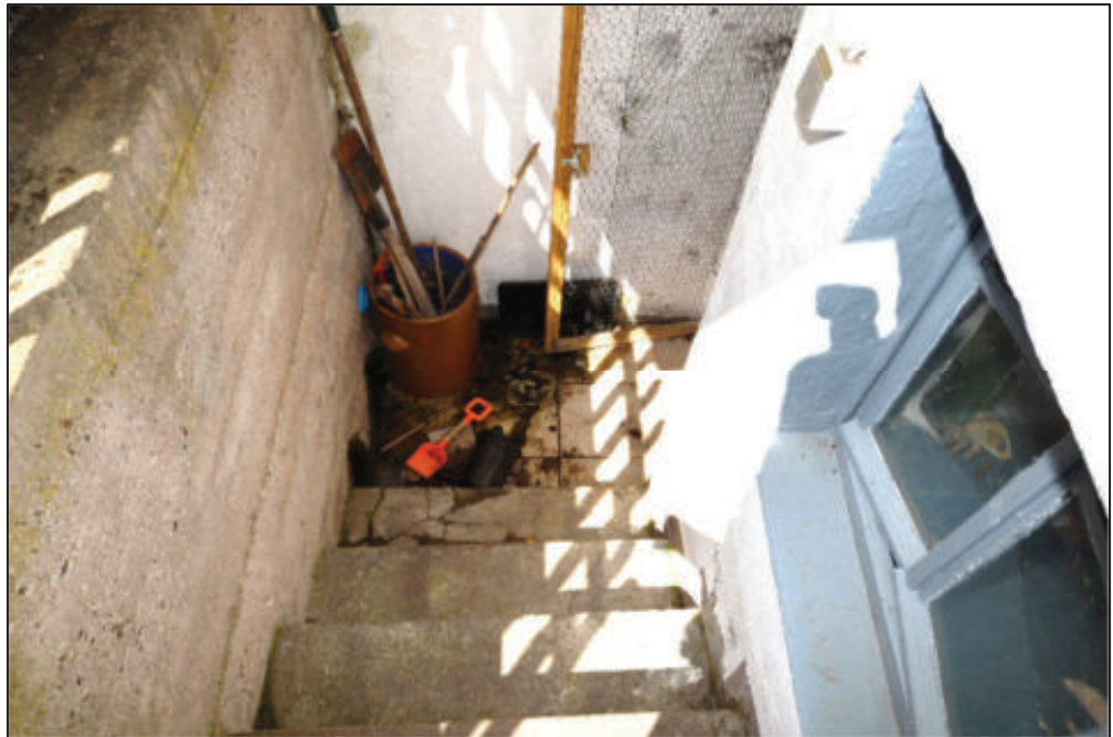
Außentreppe zu Kellerraum (Anbau)
