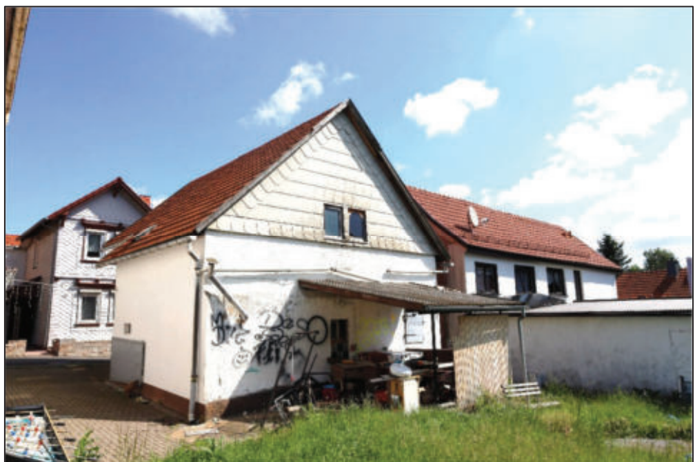
Südwestansicht – Nebengebäude (Scheune)
