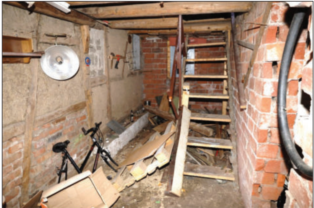
provisorische Treppe zum DG
