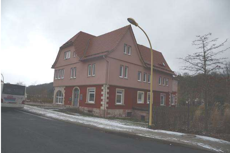
FOTO 1 ANSICHT VON STRAßENRAUM
