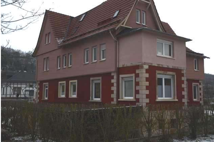
FOTO 1 NORD- OST- ANSICHT DES WOHN- UND GESCHÄFTSHAUSES
