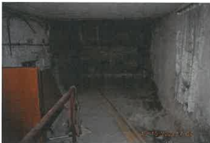
Bereich unter einer Terrasse
