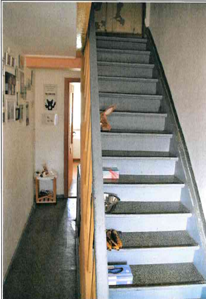
Innentreppe zum Dachgeschoss
