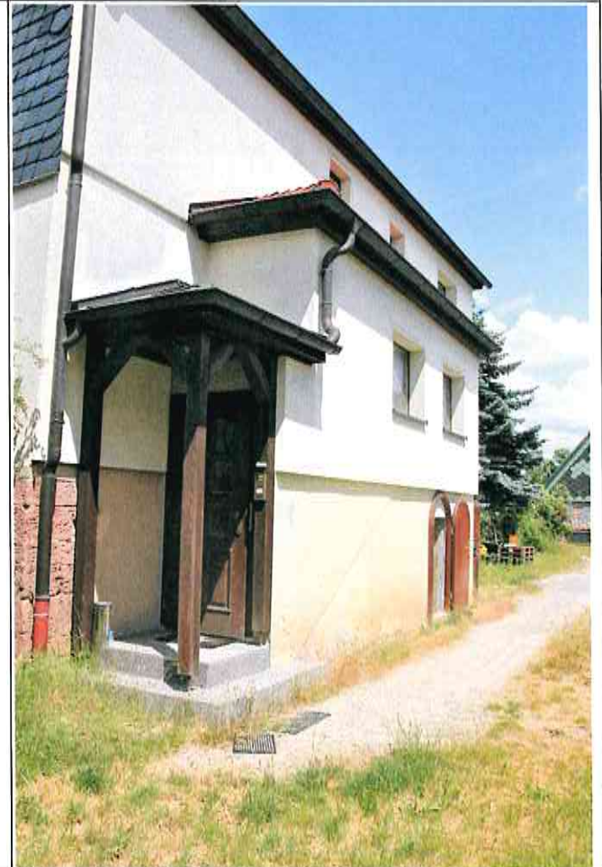
Südansicht (Windfanganbau offensichtlich Überbau)
