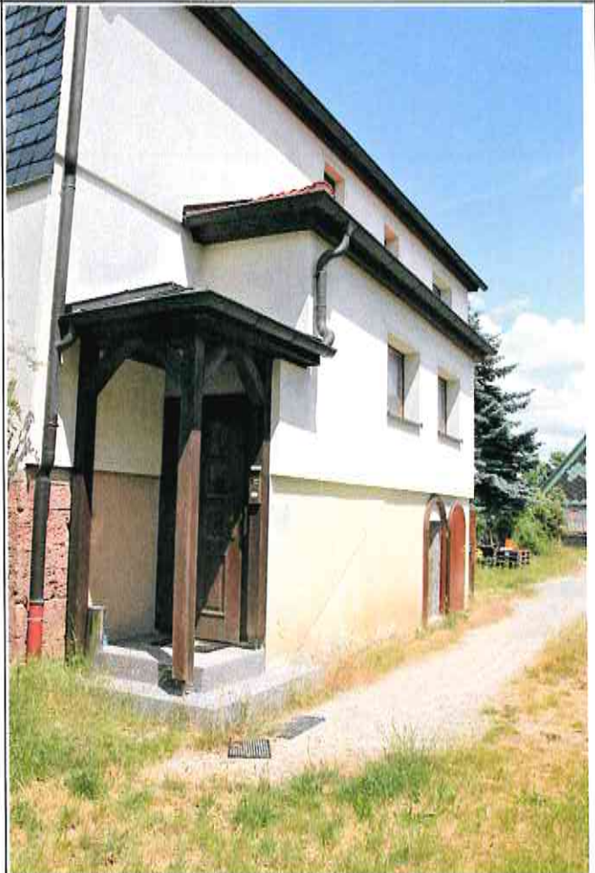
Südansicht (Windfanganbau offensichtlich Überbau)
