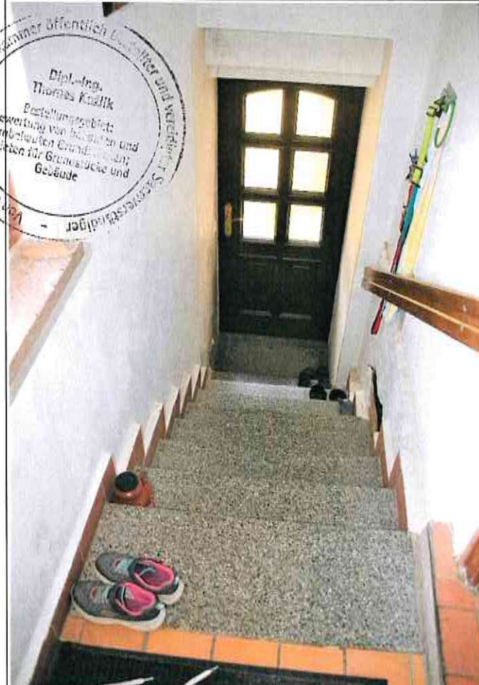
Innenbereich Windfang (offensichtlich Überbau auf 223)
