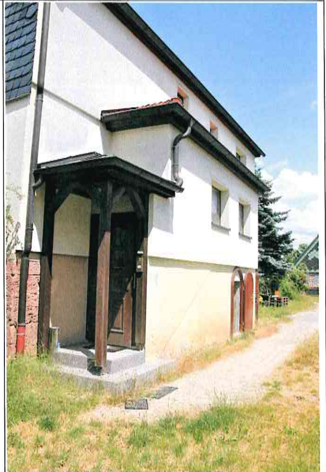
Südansicht (Windfanganbau offensichtlich Überbau)
