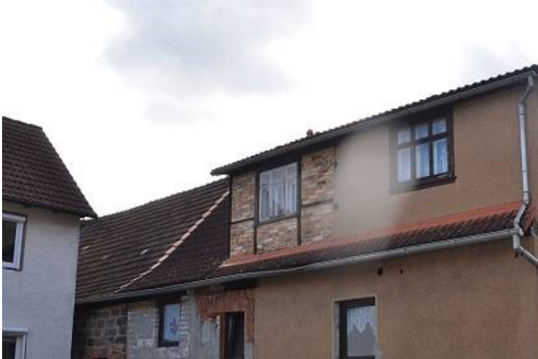
Foto 1 Wohnhaus NORD- OST-ANSICHT DES WOHNHAUSES VOM STRAßENRAUM AUS
