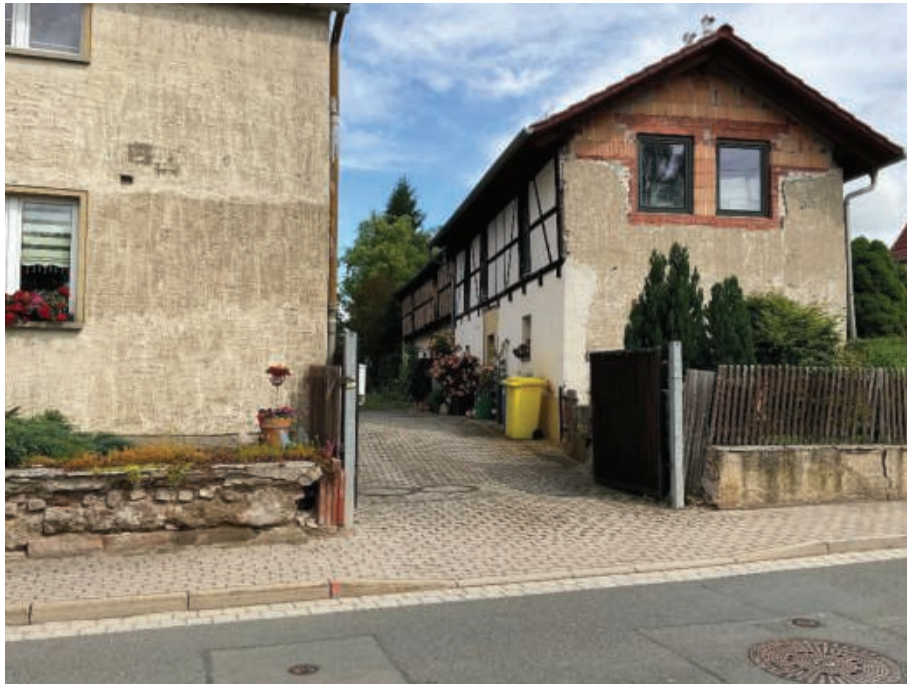
Wohnhaus westlicher Grundstücksteil -Leerstand,Sanierung begonnen
