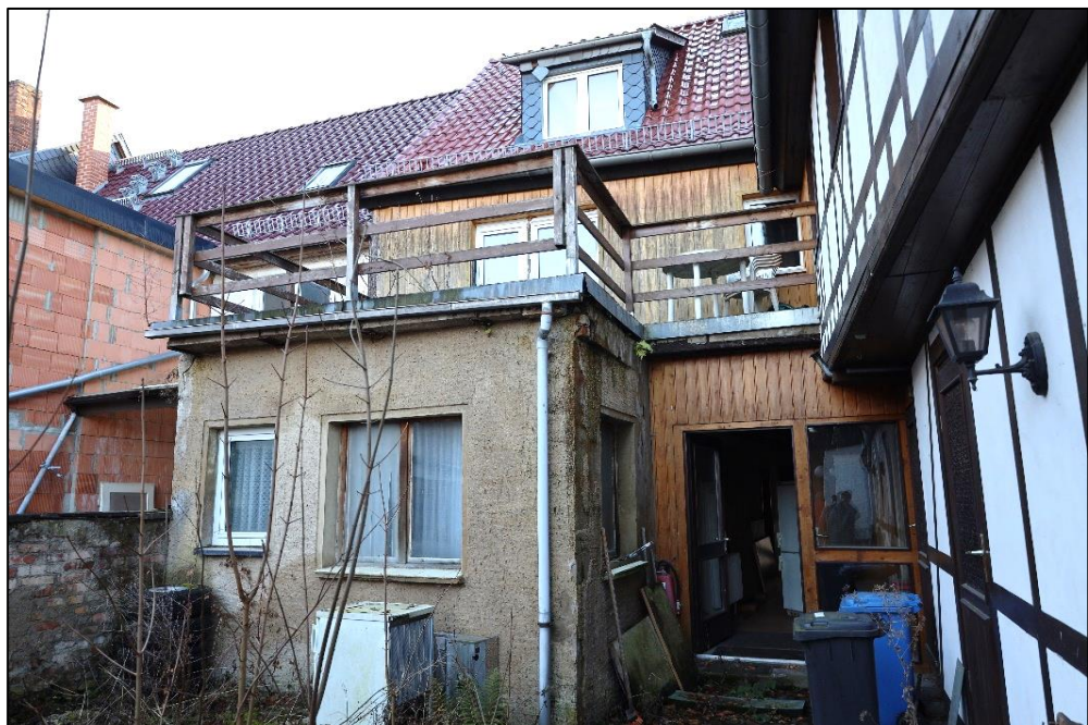
Nordansicht - Wohn- und Geschäftshaus
