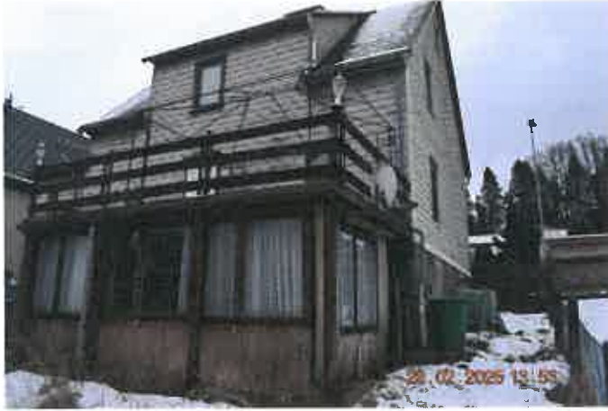
rückwärtige Gebäudeansicht mit Anbau
