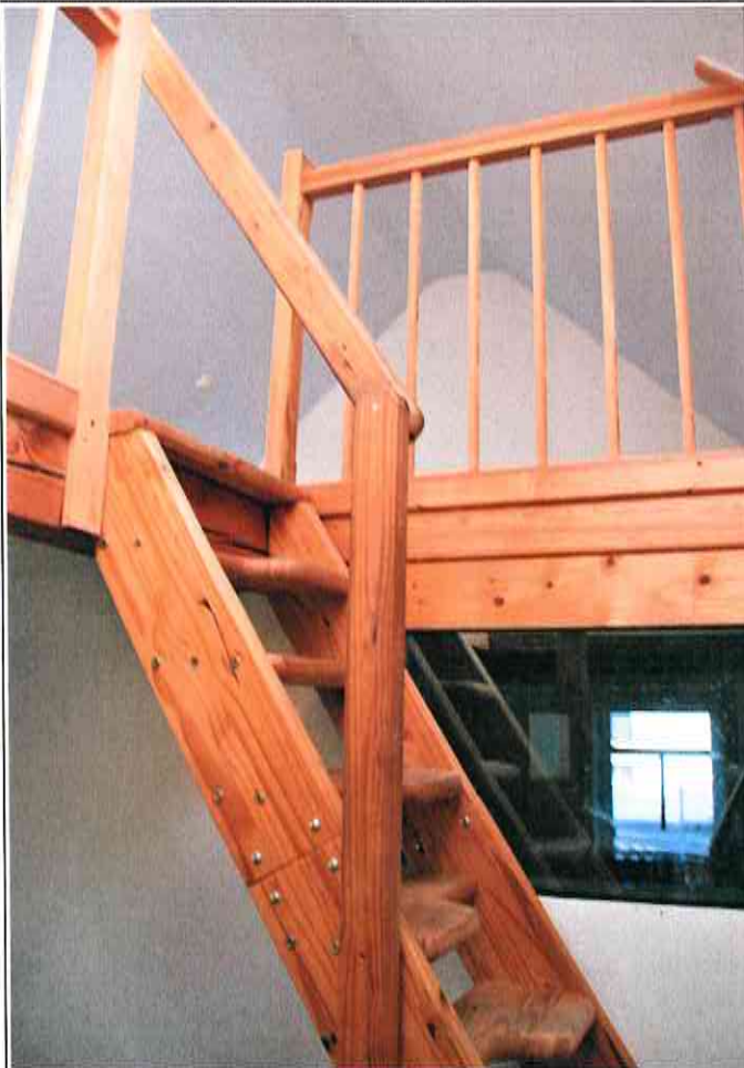
Wohnhaus Treppe zum Spitzboden
