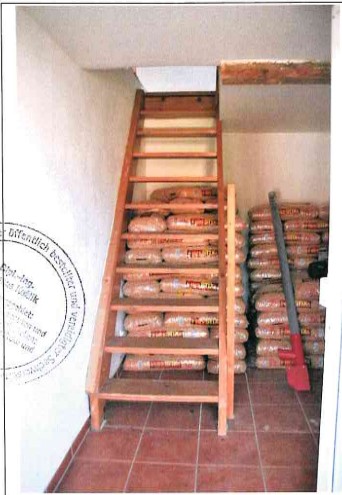
Wohnhausanbau Erdgeschoss Flur
