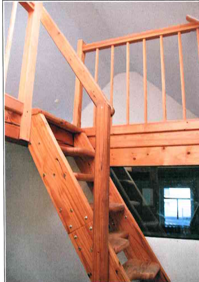
Wohnhaus Treppe zum Spitzboden
