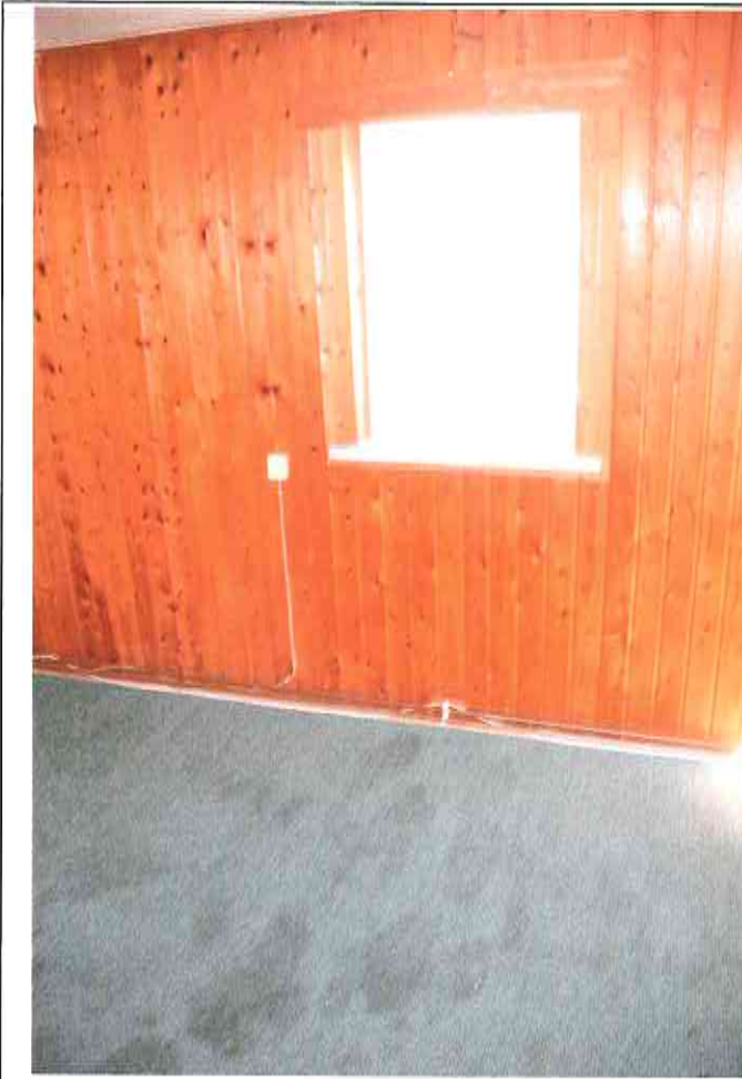
Wohnhaus Erdgeschoss Wohnraum
