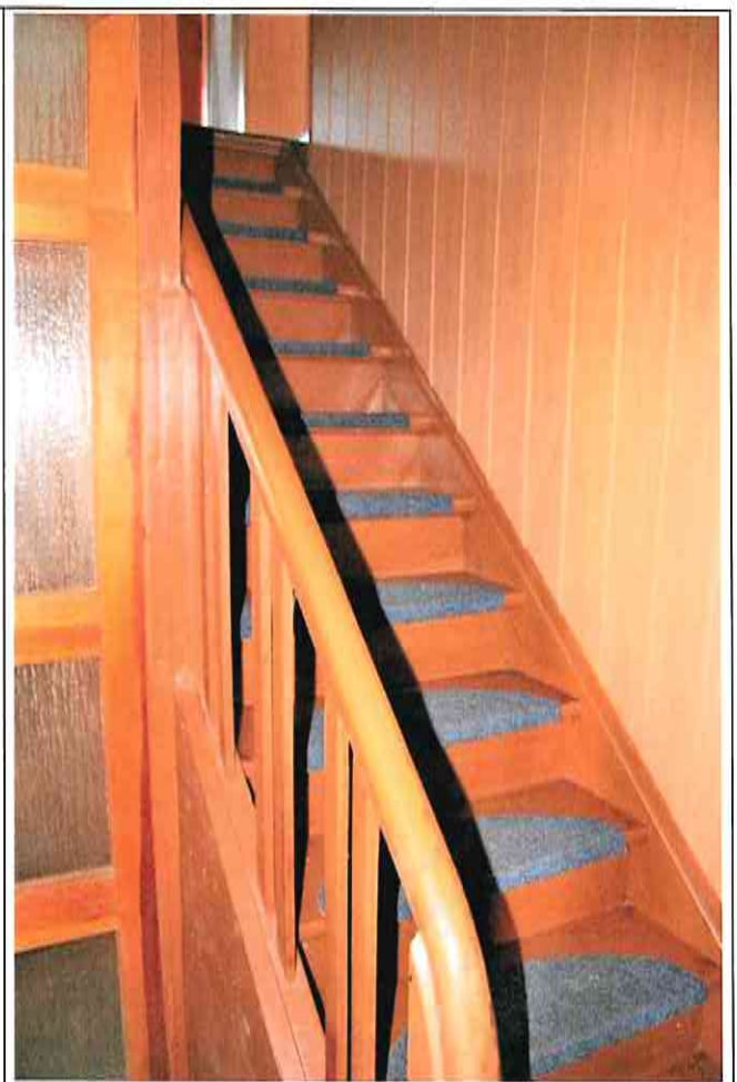
Wohnhaus Erdgeschoss Treppe zum Obergeschoss
