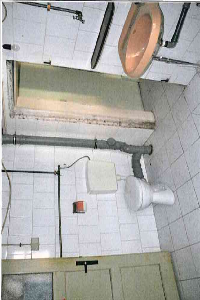
Wohnhaus Erdgeschoss WC
