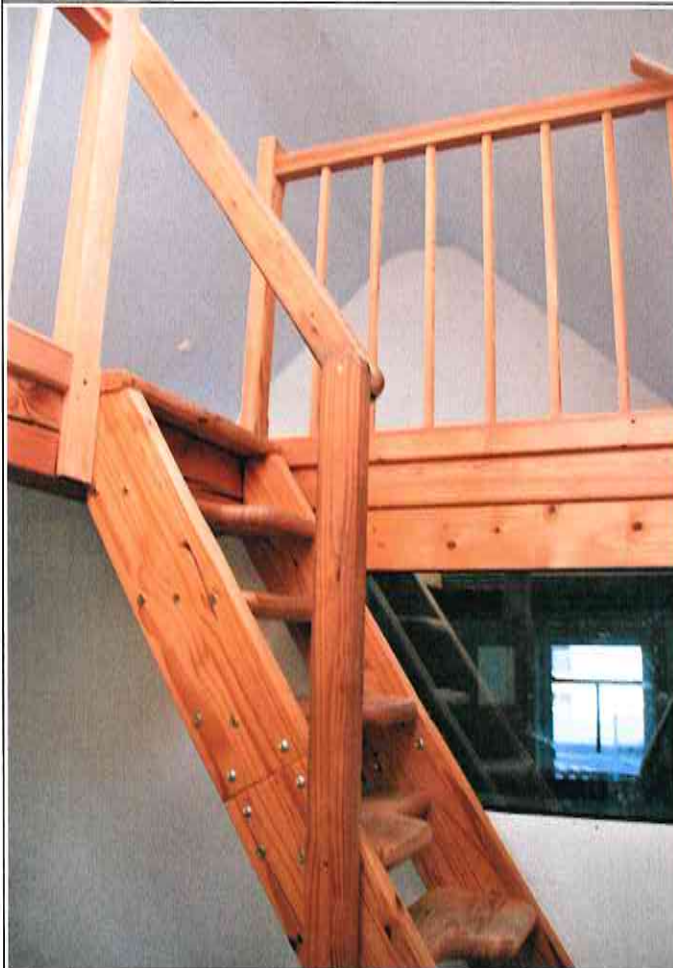
Wohnhaus Treppe zum Spitzboden
