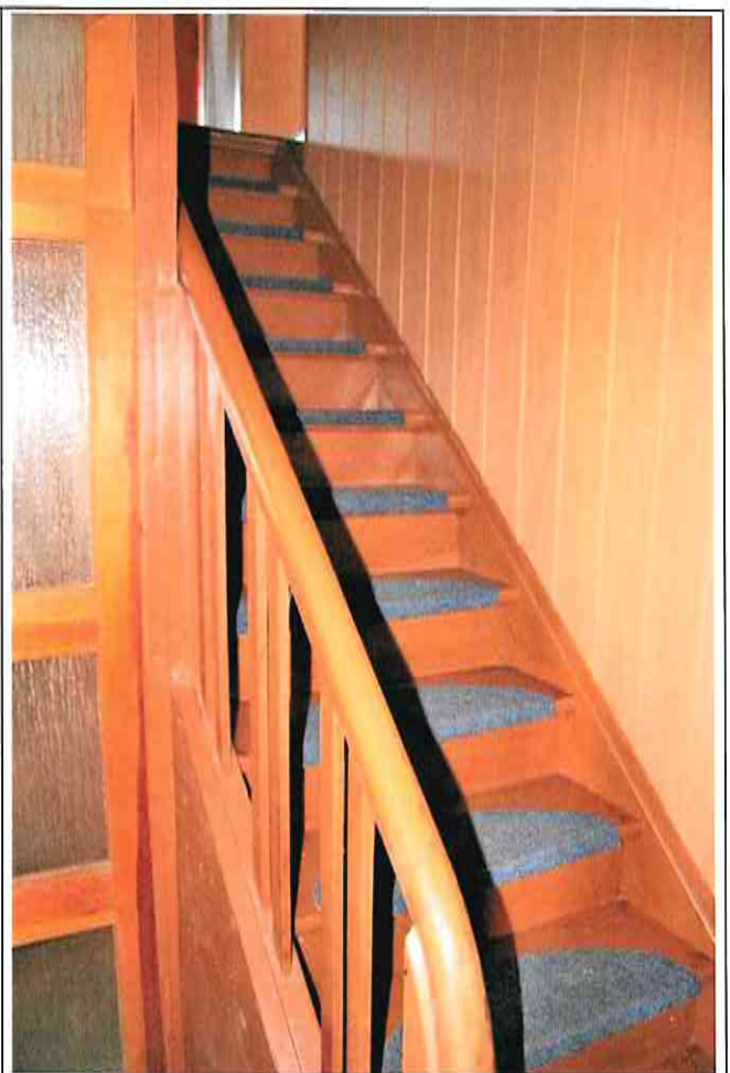
Wohnhaus Erdgeschoss Treppe zum Obergeschoss
