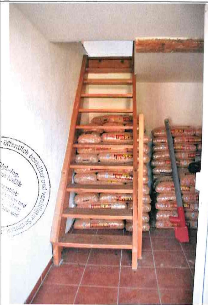
Wohnhausanbau Erdgeschoss Flur
