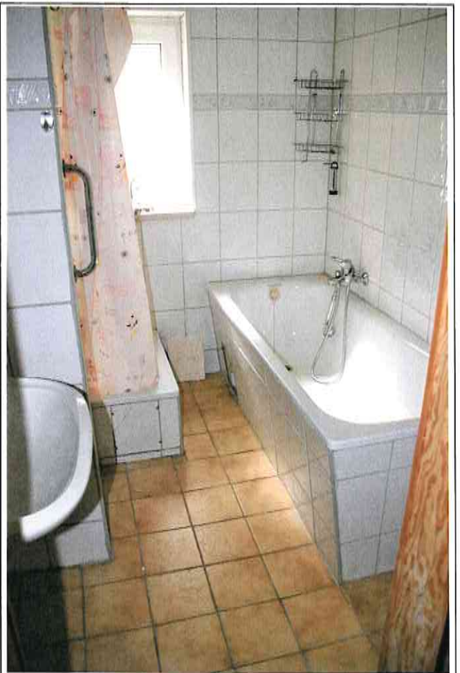
Wohnhaus Erdgeschoss Bad
