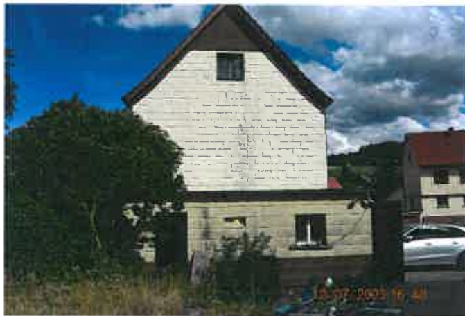
giebelseitige Ansicht Wohnhaus und Garagenanbau
