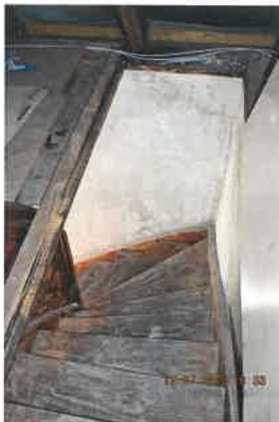
Treppe zum Dachboden
