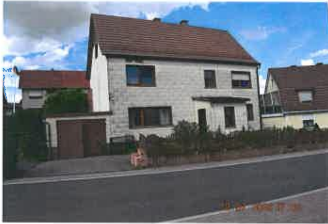
Straßenansicht Wohnhaus mit Garagenanbau
