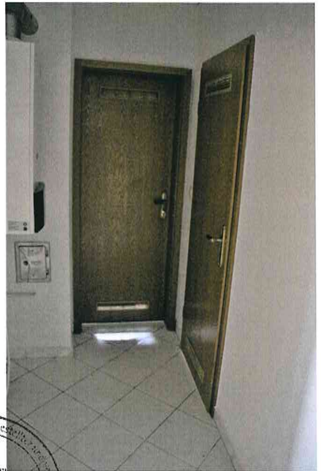
Wohnhaus Erdgeschoss Innenflur
