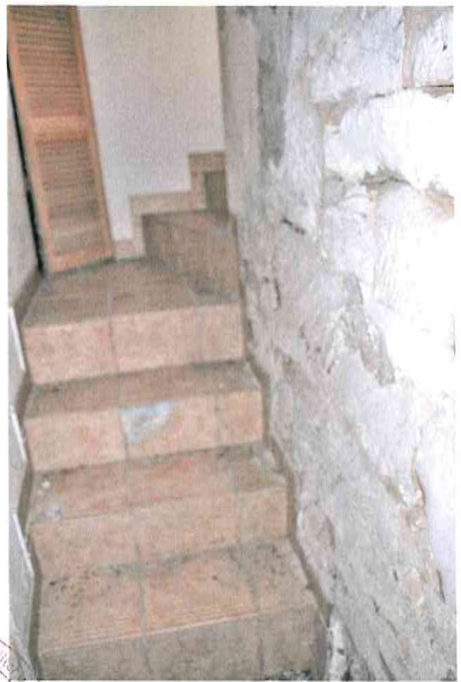
Wohnhaus Innentreppe zur Teilunterkellerung
