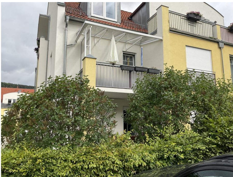
WE Nr. 4 , OG, Südseite, mit Balkonüberdachung.
