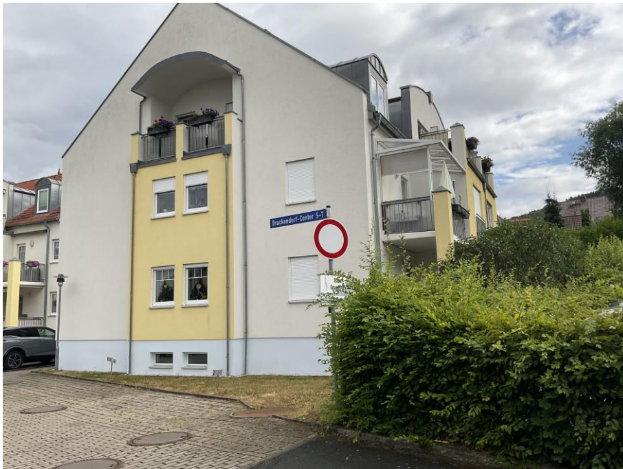
WE Nr. 4 , OG , Westseite , Wohnung mit Balkonüberdachung,
