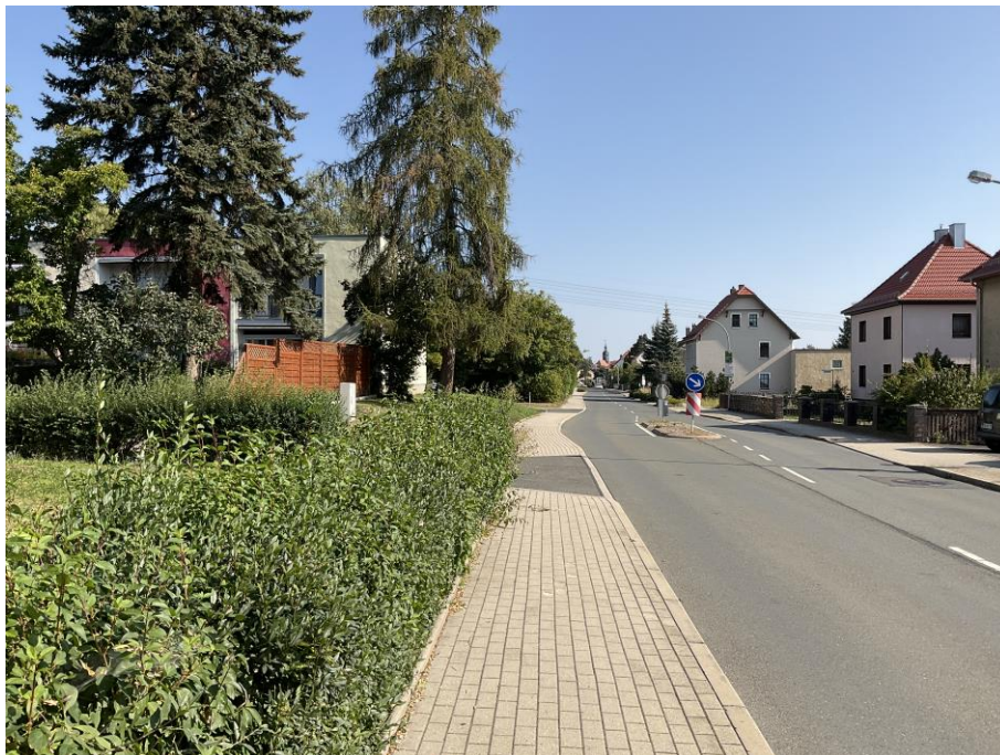
Bebauung in der Rodaer Straße
