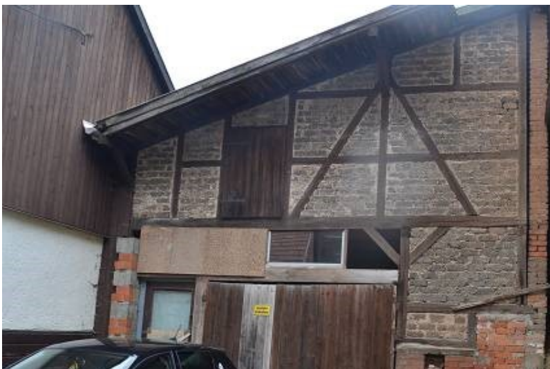
Foto 17 NEBENGEBAUDE MIT GARAGENTOR
