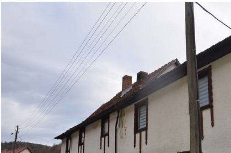
Foto 3 ANSICHT VOM HINTERRAUM
