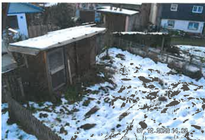
ehemaliges Hühnerhaus auf dem Flurstück 65/9
