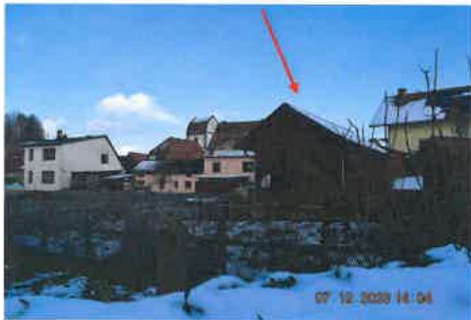
Außenansicht Giebelansicht, Gebäude auf Flurstück 75
