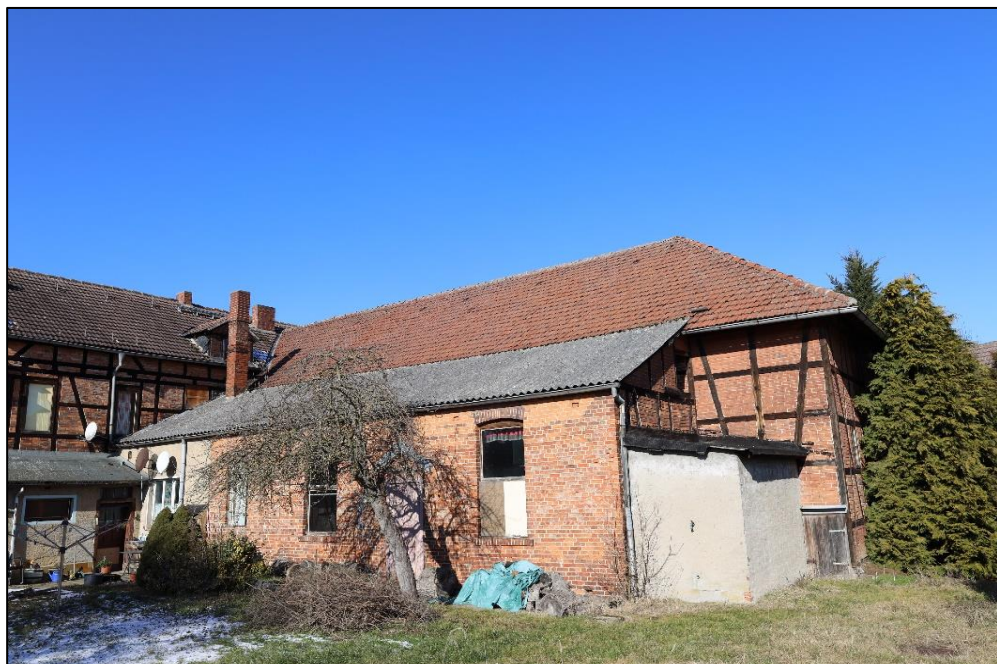
Südansicht - Ländliches Wohnhaus mit Saal
