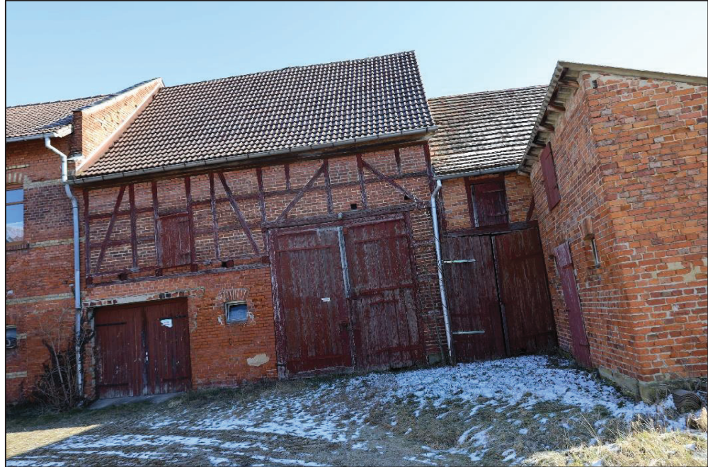
Nordostansicht - Scheune mit Anbauten
