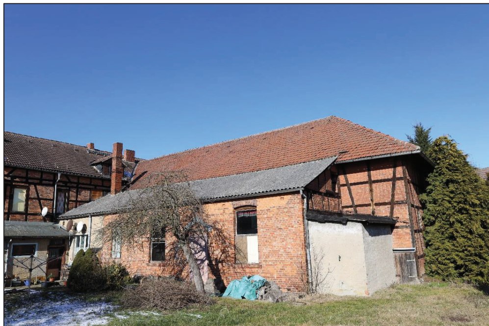
Südansicht - Ländliches Wohnhaus mit Saal
