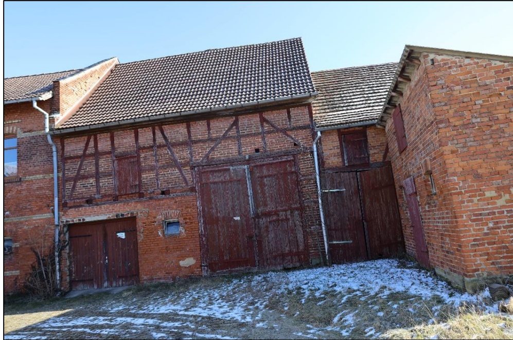
Nordostansicht - Scheune mit Anbauten
