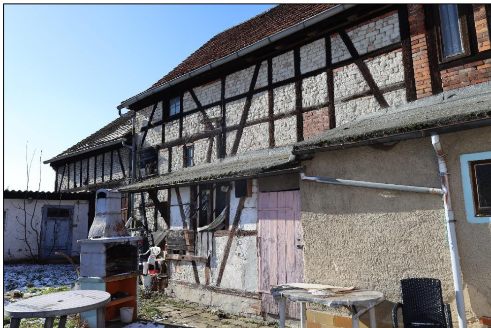
Ostansicht - Scheune mit Anbauten
