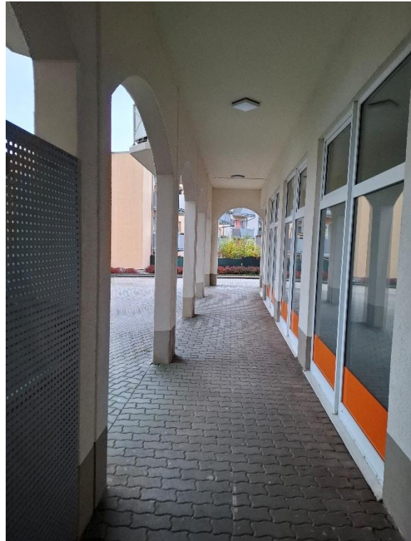
Durchgang zw. Gebäudeteilen
