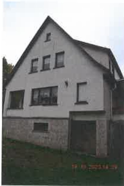
giebelseitige Ansicht Wohnhaus
