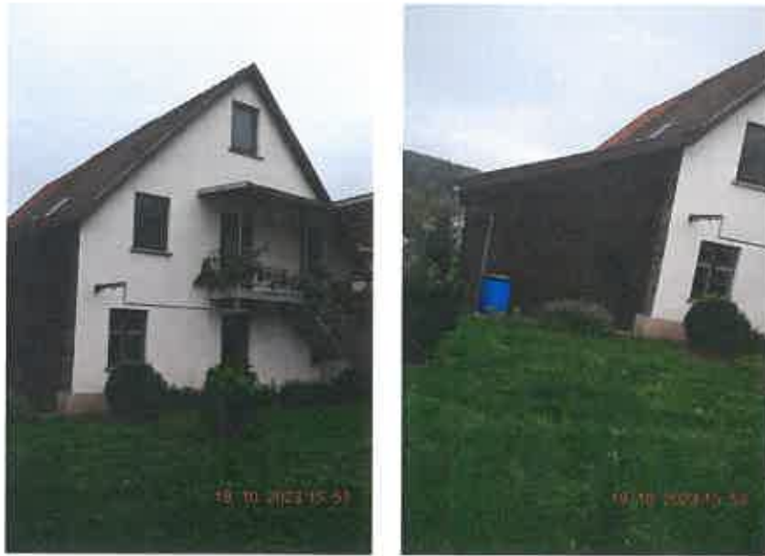
giebelseitige Ansicht mit Schuppenanbau
