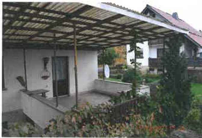
überdachte Terrasse auf Anbau
