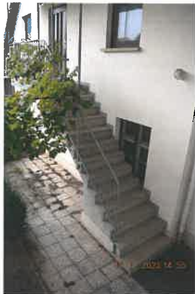
Treppenaufgang zum Ober-/Dachgeschoss
