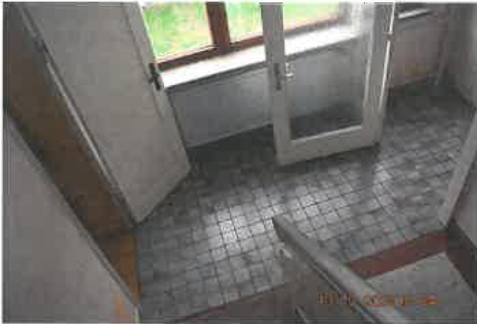
Vorraum (Anbau aus den 80er Jahren)
