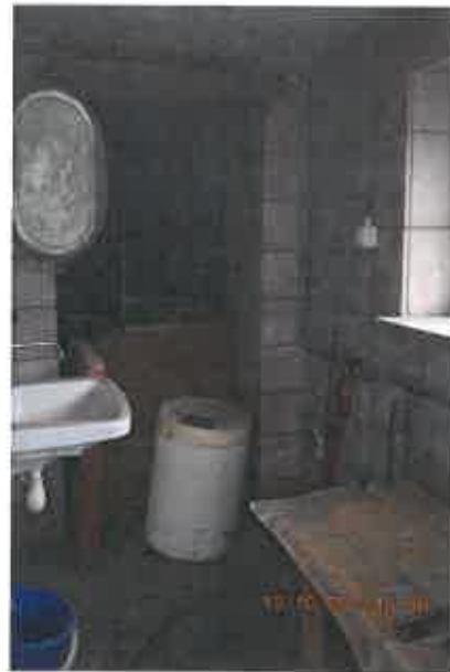
Raum im Anbau
