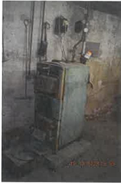
alte Schwerkraftheizung
