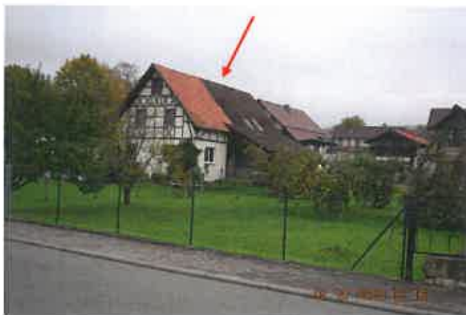
Außenansicht ehemalige Scheune mit Schuppenanbau
