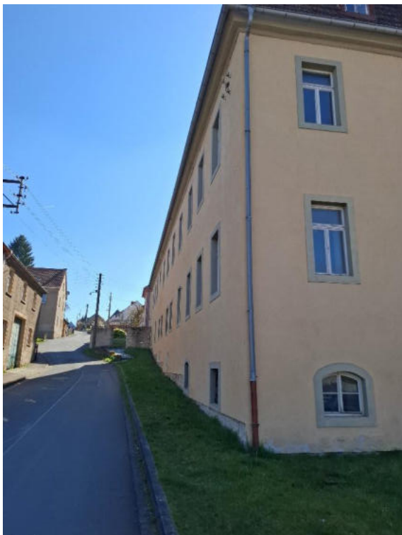
Ansicht Ostseite (Straße Am Kirchberg)
