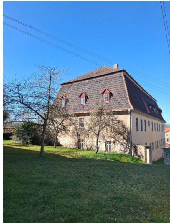
Ansicht Südseite vom Kirchgrundstück aus
