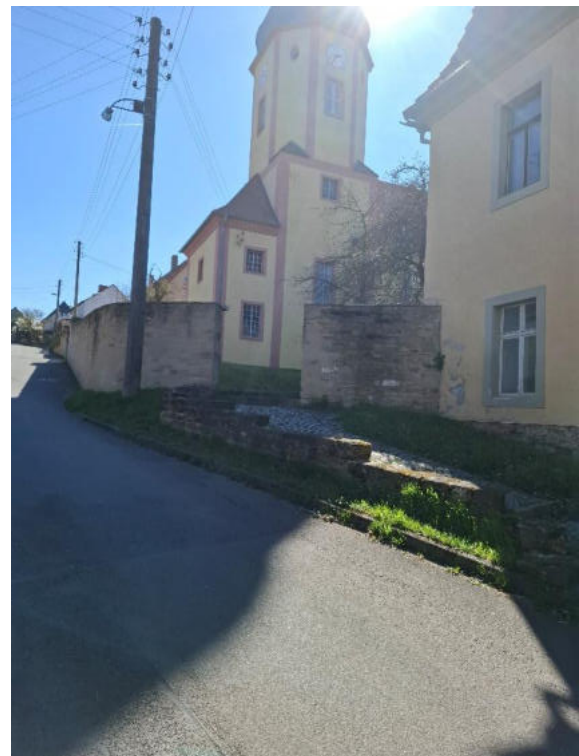
Eingang zum Kirchgrundstück
