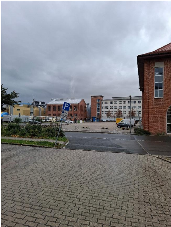
Parkplatzflächen (westl. Grundstücksteil)
