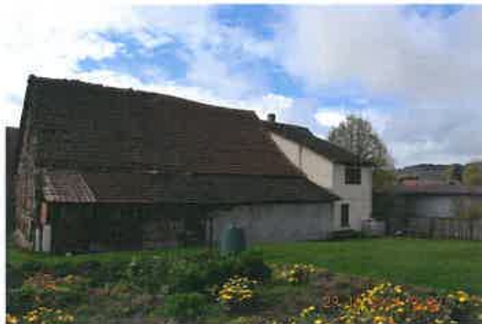
rückwärtige Ansicht Wohnhaus und Scheunenbereich
