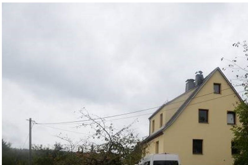
Foto 6 AUßENANLAGEN UND GRUND- STÜCKSEINFABRT
