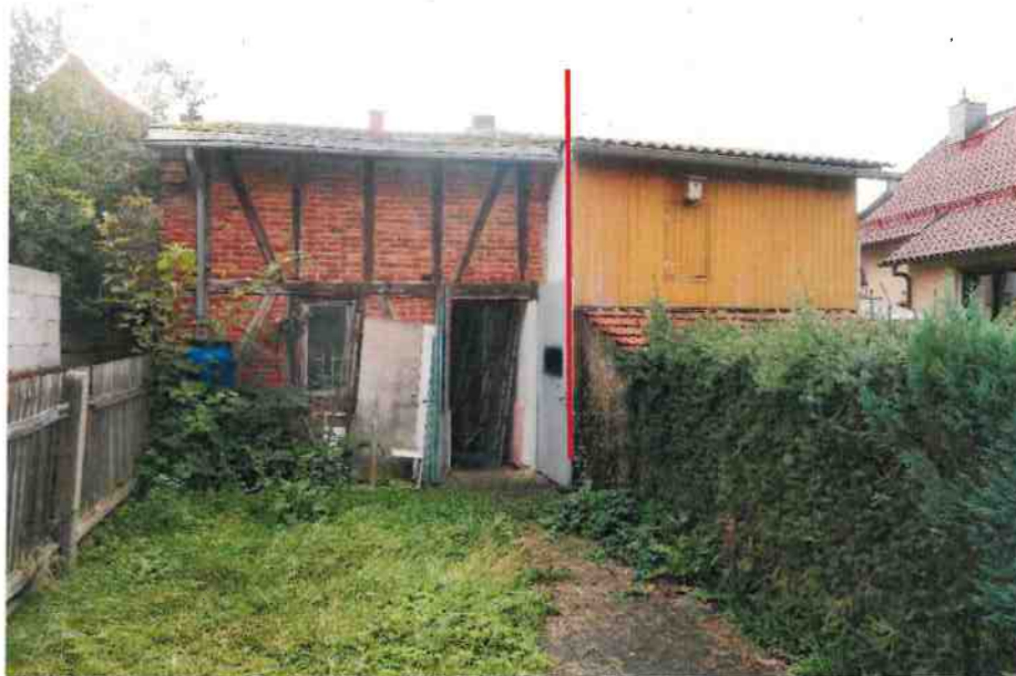
Bild 9: Nebengebäude gartenseitig, Nachbarbebauung angrenzend
