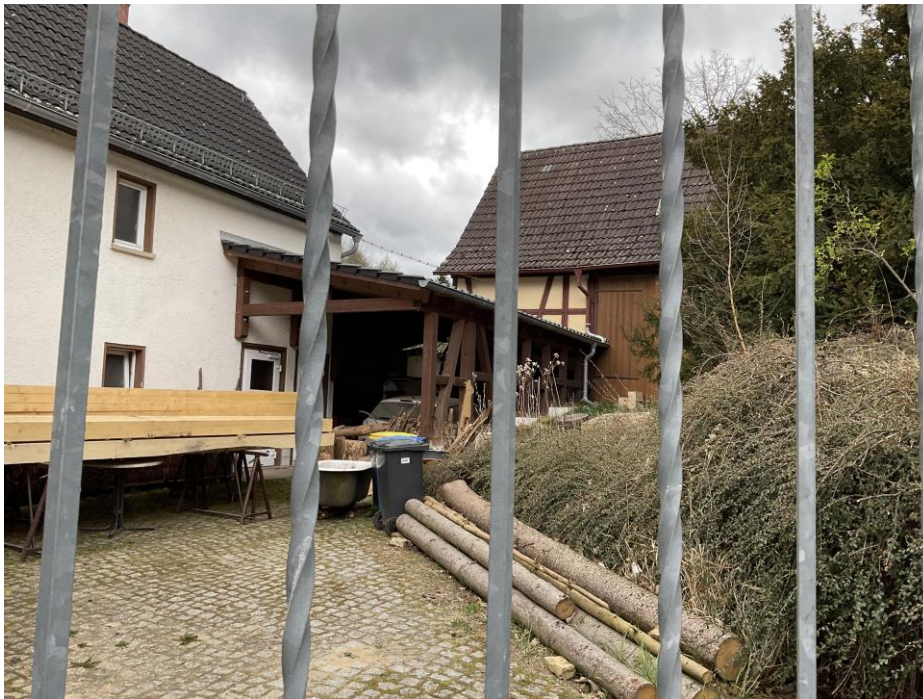
Hofansicht mit Hofüberdachung; Hofscheune
