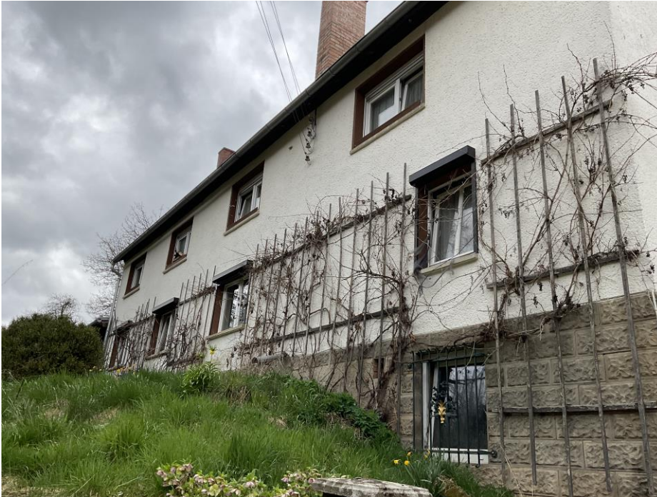
Südseite mit Teilunterkellerung
