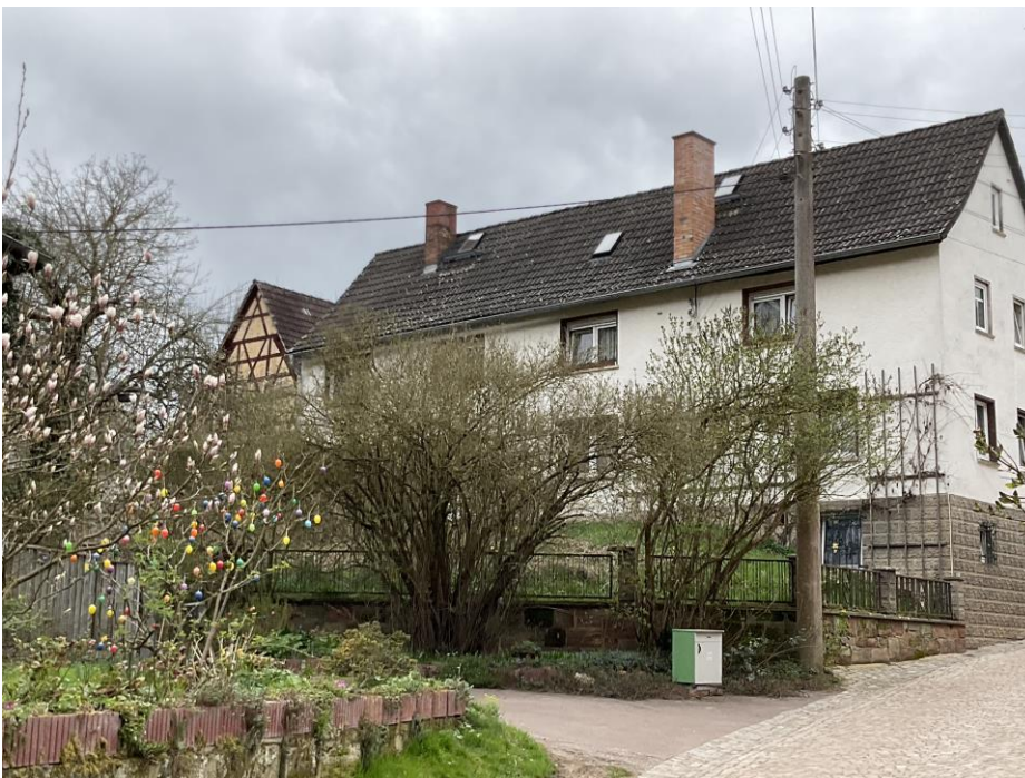
Seitenansicht mit Hofscheune
