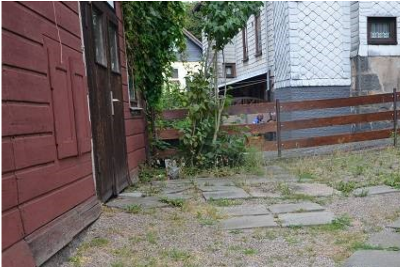
Foto 22 EINFAHRT UND HOFBEFESTIGUNG
