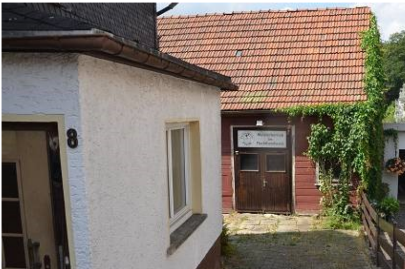
Foto 3 WINDFANGANBAU UND HOFEINFAHRT
