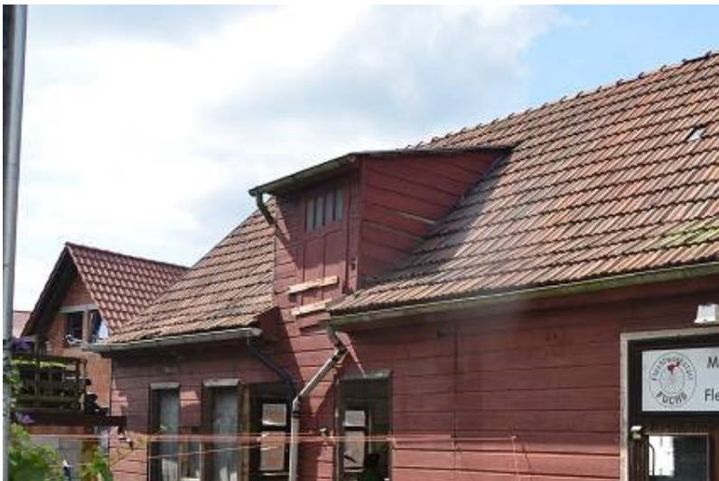
Fotos 17-21 EHEMALIGES WERKSTATTGEBÄUDE
