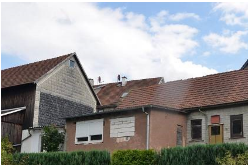
Foto 18 ANSICHT VOM HINTERRAUM
