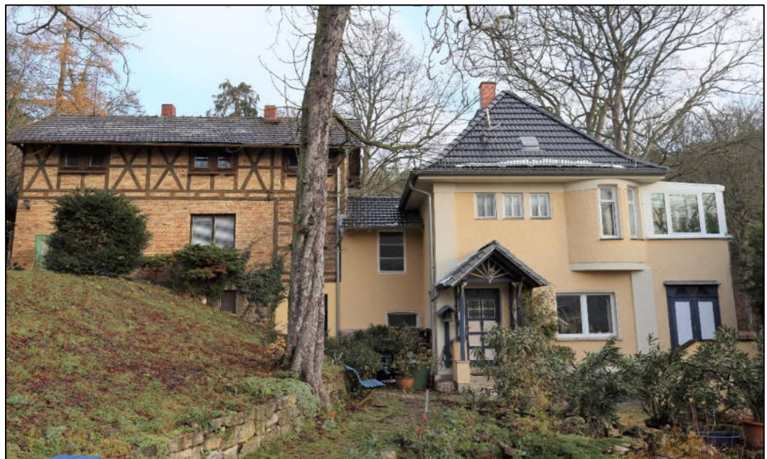
Südwestansicht - Wohnhaus mit Anbau
