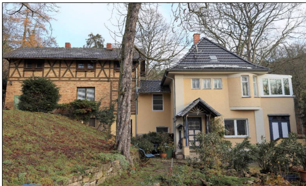
Südwestansicht - Wohnhaus mit Anbau
