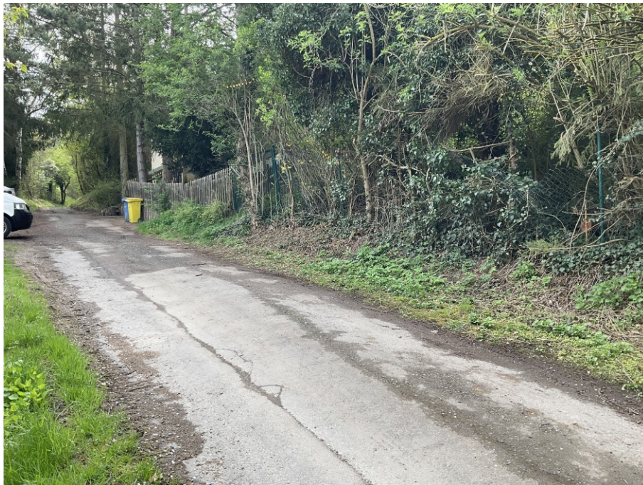
Straße befestigt mit Übergang unbefestigt – Richtung Ziegenhain
