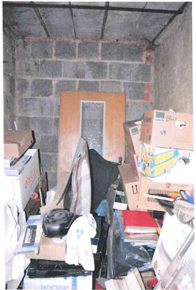
Wohnhaus Erdgeschoss Gebäudeverlängerung
