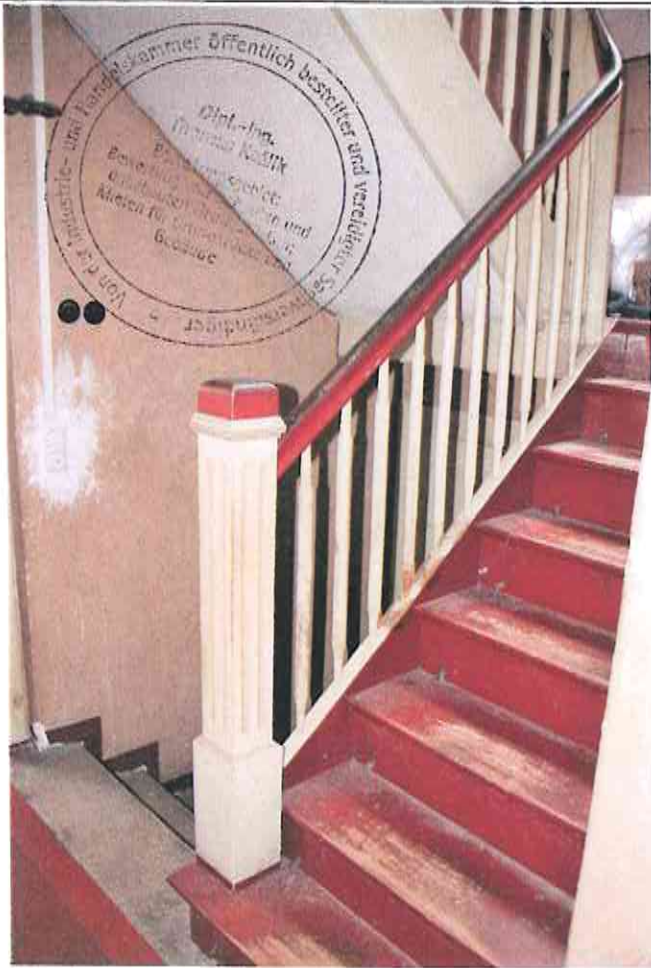
Wohnhaus Erdgeschoss Flur/Treppenraum
