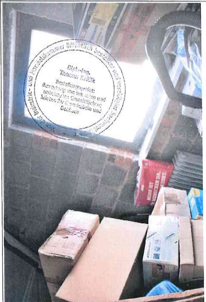
Wohnhaus Dachgeschoss Gebäudeverlängerung
