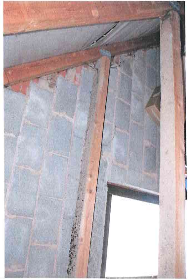
Wohnhaus Dachbereich Gebäudeverlängerung
