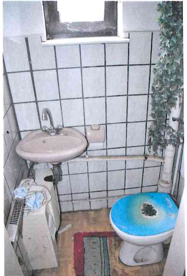
Wohnhaus WC „halbe“ Treppe zum Keller
