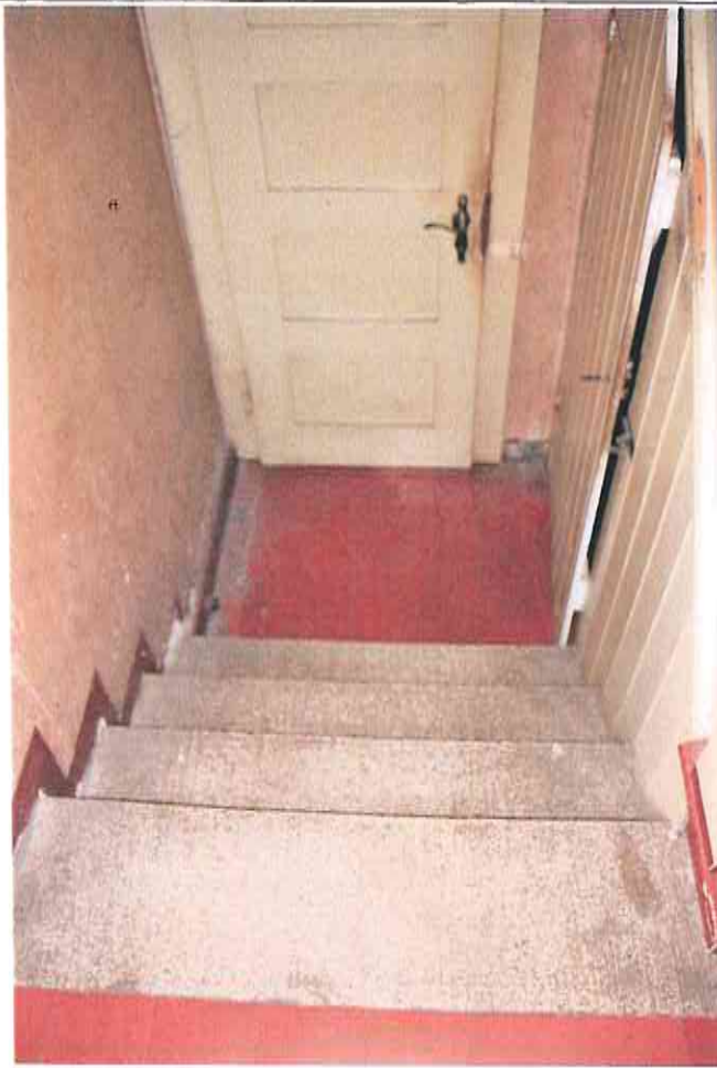
Wohnhaus Treppe zum WC und Kellergeschoss
